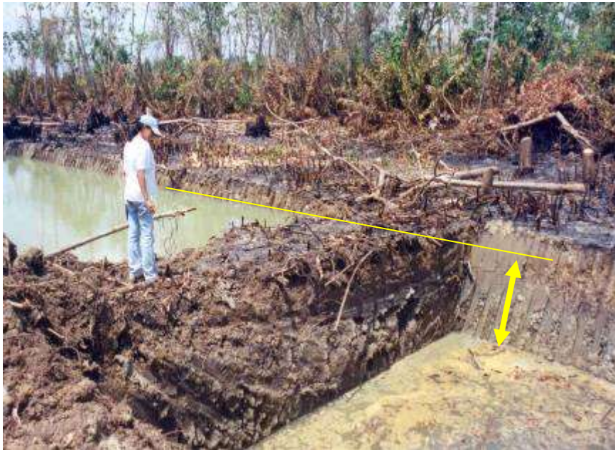
Figura 1.1. En este humedal el agua no cubre la superficie del sustrato sino que subyace a éste. El agua que está llenando la fosa a la derecha se filtra desde el sustrato pocos minutos después que una retroexcavadora abre la zanja. Nótese la diferencia de nivel (línea amarilla), en la fosa del lado izquierdo con respecto a la fosa de la derecha): eventualmente ambos niveles se igualan (fotografía tomada en abril de 2003 en la vía que conduce desde Guanare hacia la población de Papelón en el estado Portuguesa).
