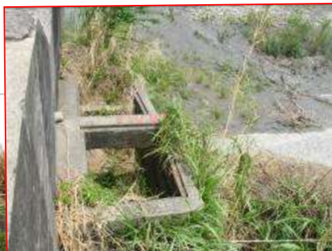
A la izquierda, señalada con una flecha, escalera de peces en el Río Guanare; está situada a un costado del aliviadero del cimacio. En el inserto, vista superior de la estructura de la escalera (fotografías tomadas en abril de 2007)
